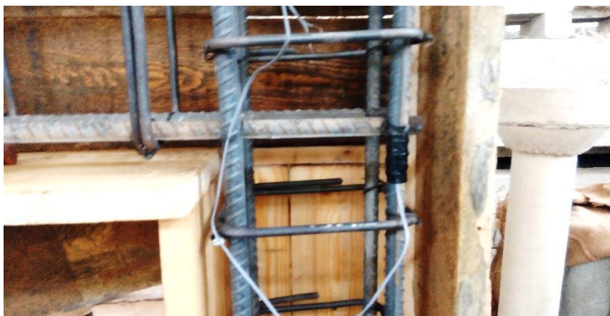
5-a) Steel Bars
