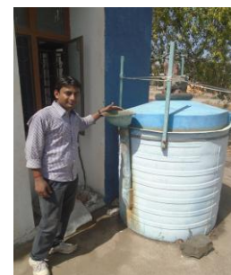
Figure 5.2 Biogas plant at UIT RGPV BHOPAL
